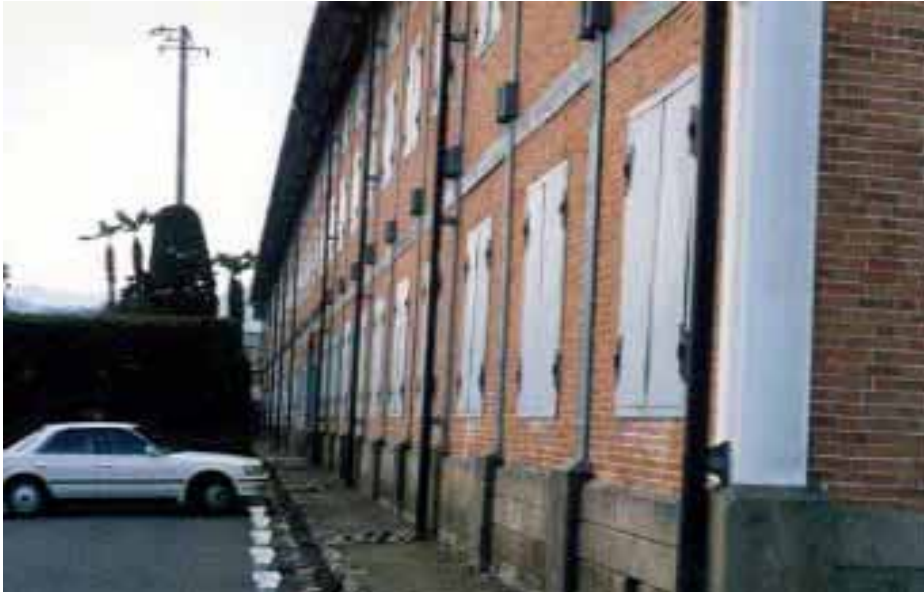
写真 3 . 礎石と通し柱の様子
