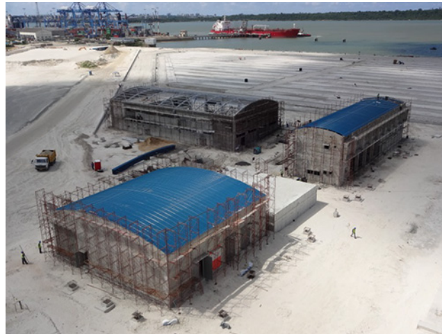
図12 建築構造物の同時施工の様子
